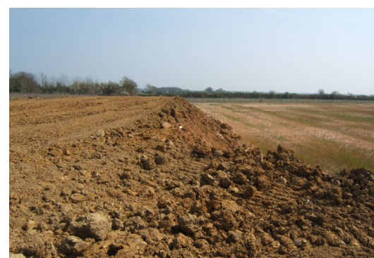
Les terres de découverte mise en dépôt sur le site
