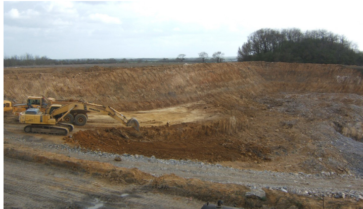
Travaux de découverte sur La Rousselière
